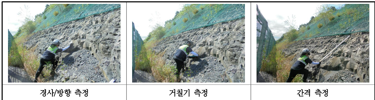
【사진 57.3.3】 불연속면 측정 현황
